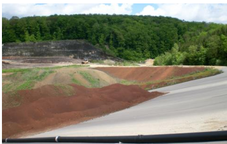
Ca. 14'000 m 3 Rückbaumaterial in Deponie im 2024
