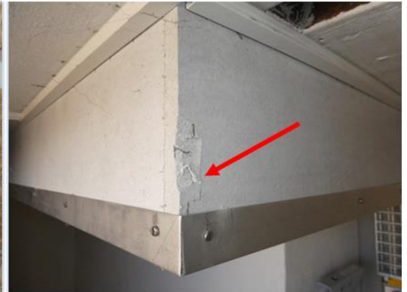
Pressplatten als Belüftungskanal
